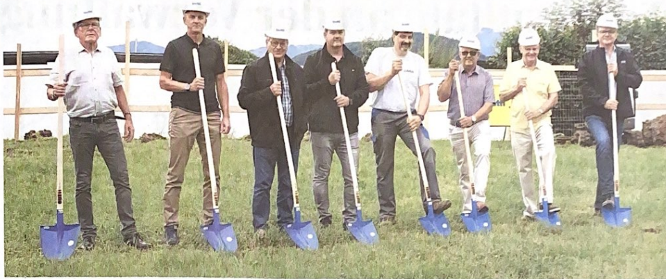
Gaben mit dem symbolischen Spatenstich den Startschuss zum Bau der Erweiterung: (v. l.) Ruedi Steiner (Vize-Präsident Zweckverband ARA Untermarch), Eusebio Müller (Butti), Peter Kohler (Hagedorn), Roland Knobel (Bauleiter), Noldi Kistler (Klärwerkleiter), Armando Zweifel (Präsident Zweckverband ARA Untermarch), Erwin Schättli (ehemaliger Präsident ARA Untermarch) und Fritz Wüthrich (Gesamtplaner Kuster + Hager). Bild Hans-Ruedi Rügeggger
