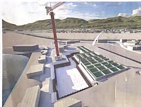
Aufgrund des unsicheren Baugrundes müssen die Bauwerke auf Pfählen erstellt werden (links). Die neue Anlage zur Eliminierung der Mikroverunreinigungen kommt neben die bestehenden Klärbecken zu stehen.
