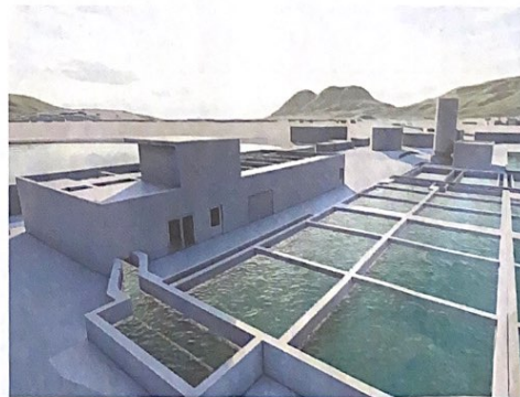
Aufgrund des unsicheren Baugrundes müssen die Bauwerke auf Pfählen erstellt werden (links). Die neue Anlage zur Eliminierung der Mikroverunreinigungen kommt neben die bestehenden Klärbecken zu stehen.
